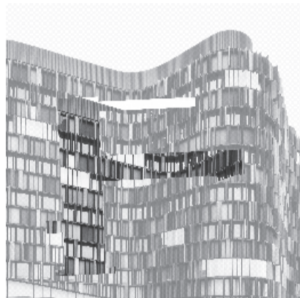
"Edificio per uffici U15"
