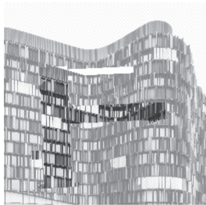
"Edificio per uffici U15"
